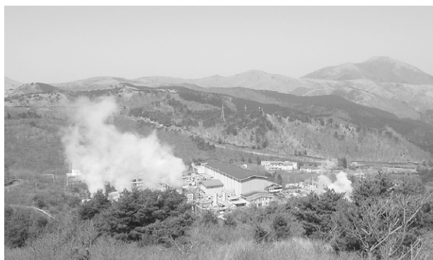
図1 八丁原地熱発電所の全景。大分県九重町にある九州電力株式会社による日本最大の地熱発電所。総出力は11万kW。
