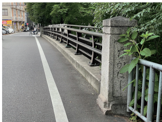
写真1：1917（大正6）年竣工の中橋
