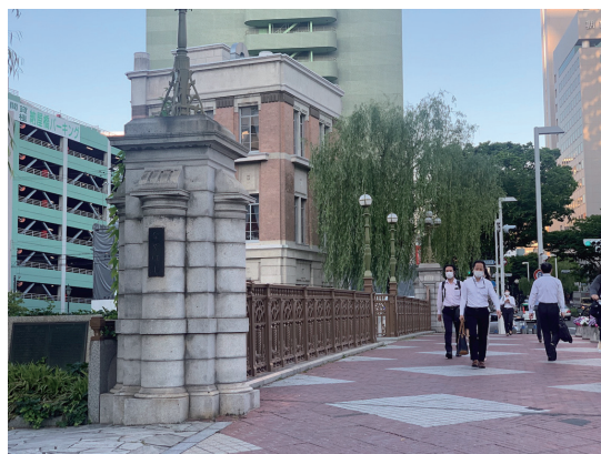
写真2：1987（昭和62）年に改修した納屋橋
