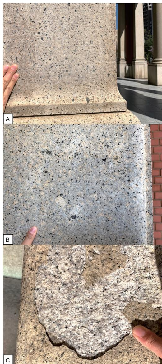
写真3 名古屋市市政資料館の外壁に使われている御影石（花崗岩） A：玄関柱，B：外壁，C：車寄せ（剥離している部分）
