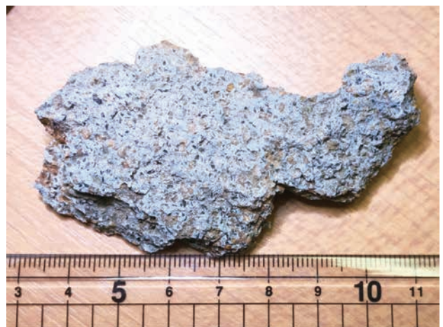
写真2 本調査で利用した名古屋市役所本庁舎外壁の剥離片。
