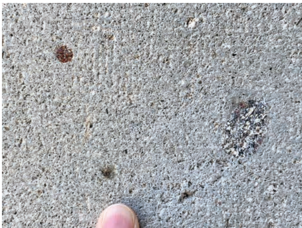
写真6 東京大学医学部附属病院管理研究棟の外壁に使われている由良石。由良石の特徴といえるザクロ石と捕獲岩を含んでいる。
