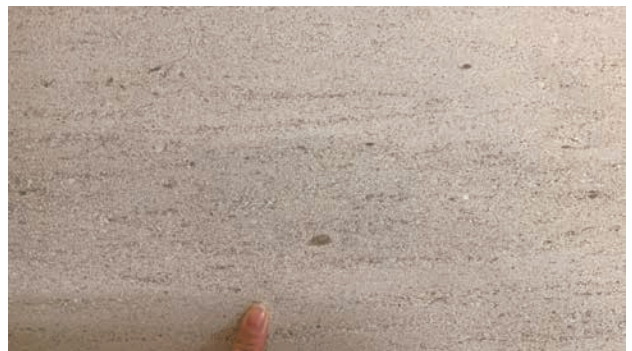
写真17 豊田商工会議所内壁の「モカクリーム」
