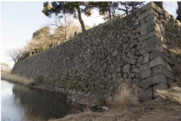
写真1 二之丸北西部石垣
