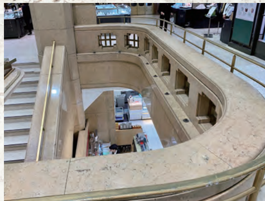
図3 イタリア産「大理石」「ネプロロザート」でつくられた日本橋高島屋S.C.本館の階段手すりや柱
